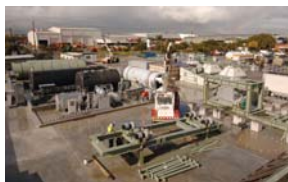
Welshpool Asphalt, WA
