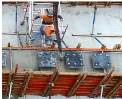
Trial concrete pour at Ormeau Quarry
